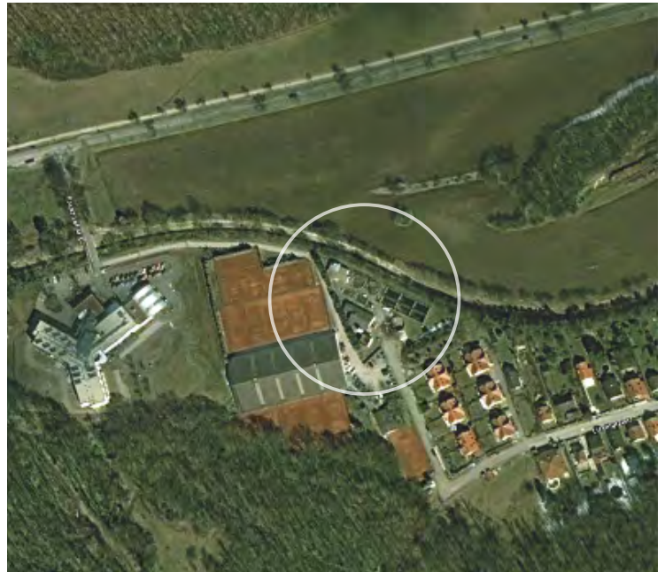
Die Kläranlage in Breitenfurt
